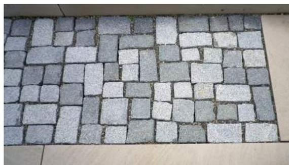
Abb. 38: Beispiel für Granitpflaster in der Fläche verlegt
