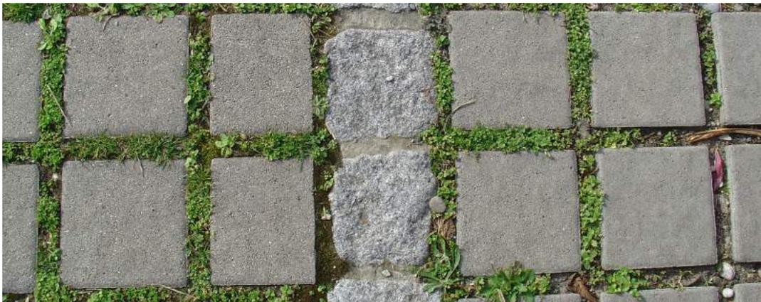
Abb. 41: Rasenfugenpflaster mit Granitpflaster zur Flächengliederung
