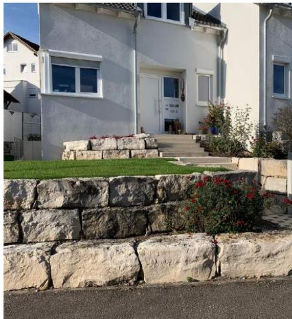
Abb. 47: Gebäudevorzone mit abgestuften Stützmauern
