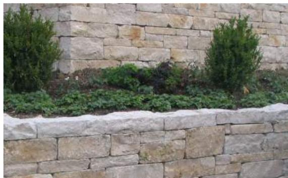
Abb. 49: Stützmauer aus Naturstein mit begrünter Stufe
