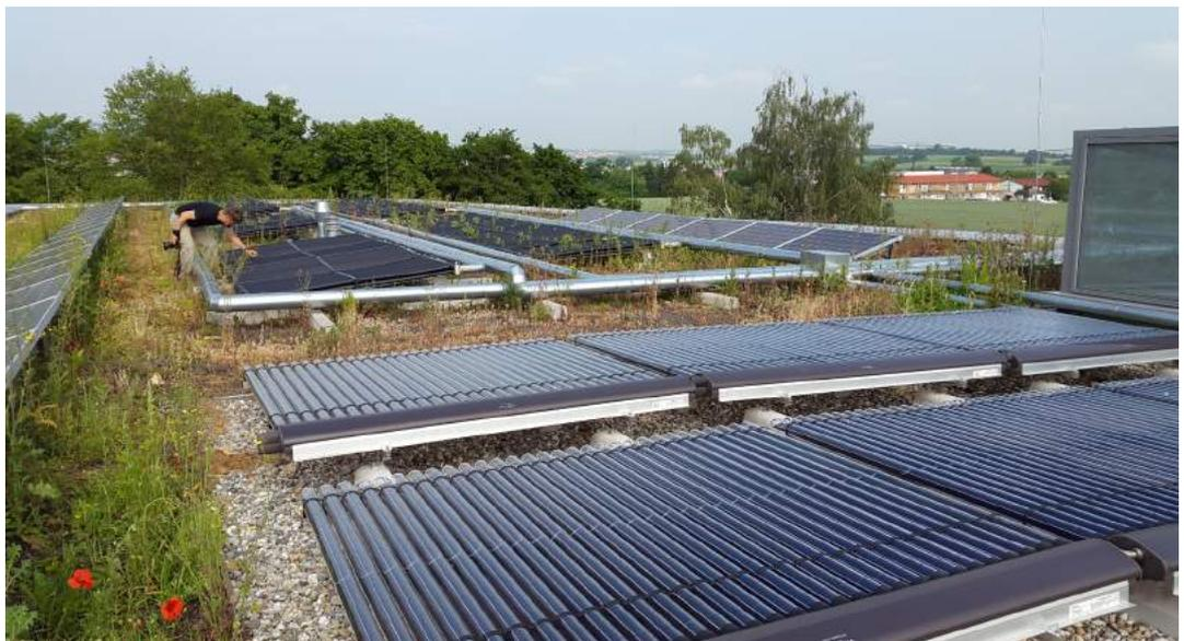
Abb. 31: Beispielhaft: Kombination von Solarmodulen mit Dachbegrünung
