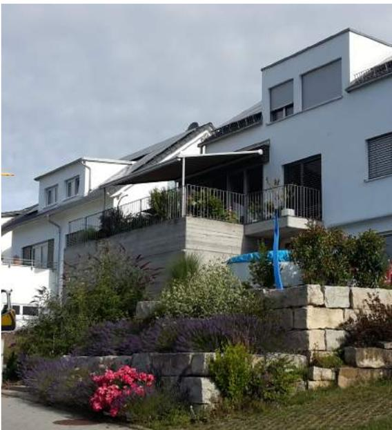
Abb. 46: abgestufte Stützmauer aus Naturstein
