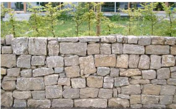
Abb. 48: Stützmauer aus Naturstein
